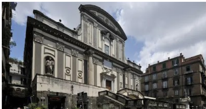
Fig.2 - facciata della chiesa di San Paolo Maggiore
